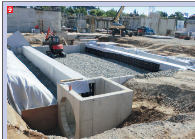
Einbau einer luftdurchströmten Schotterschüttung (Projekt aus dem Jahr 2015 ist adäquat dem beschriebenen Projektbeispiel)
